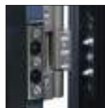
Doigt anti-soulèvement côté paumelles
