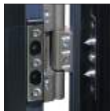
Doigt anti-soulèvement côté paumelles
